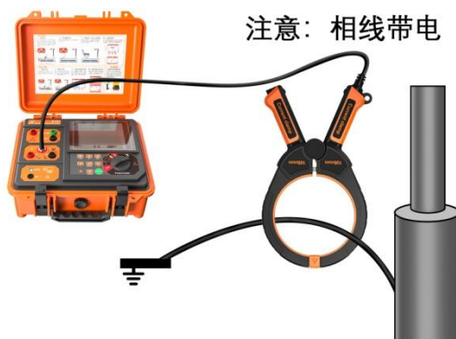
图 5- 18 运行电缆卡钳耦合法 2（卡电缆接地线）
